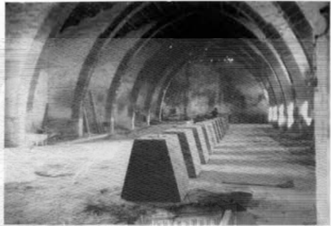
9 - MARSALA, BAGLIO ANSELMI: DENTRO LA "STANZA DELLA NAVE" UNA SETTIMANA DOPO È stato fatto un pavimento di cemento e sono stati eretti blocchi destinati a sorreggere l'antica chiglia.
