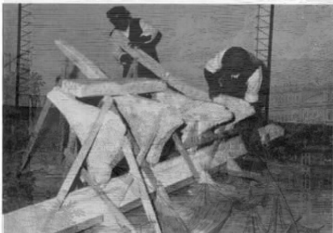
13 - MARSALA, BAGLIO ANSELMI: CALCO DI GESSO DELLE PARTI ARCHITETTONICHE PIÙ SIGNIFICATIVE DELLA POPPA. Eseguito nel 1975 prima che il legno venisse trattato, il calco resta a documentare un legname che non può essere esaminato tridimensionalmente dopo la ricostruzione. Qui, i carpentieri stanno preparando i calchi per una mostra del materiale di scavo nella scuola media del centro Pipitone di Marsala.
