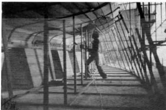
12 - MARSALA, BAGLIO ANSELMI: I SUPPORTI DELL'INTELAIATURA METALLICA REGOLABILE TELESCOPICAMENTE. Ogni piccolo errore di calcolo nella forma originale (dimostrato da un imperfetto incastro dei legni) può essere corretto alzando o abbassando i supporti di alcuni centimetri.
